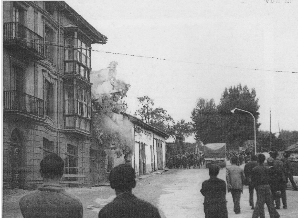
32 - CABEZÓN DE LA SAL 1963-09-06 - Derribo Edificio Bedón
