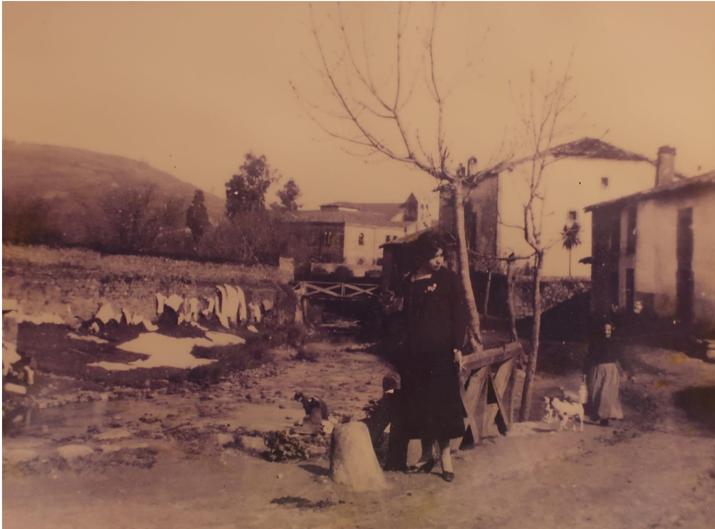
22 - CABEZÓN DE LA SAL 1908 - (aprox.) Puente del Carmen
