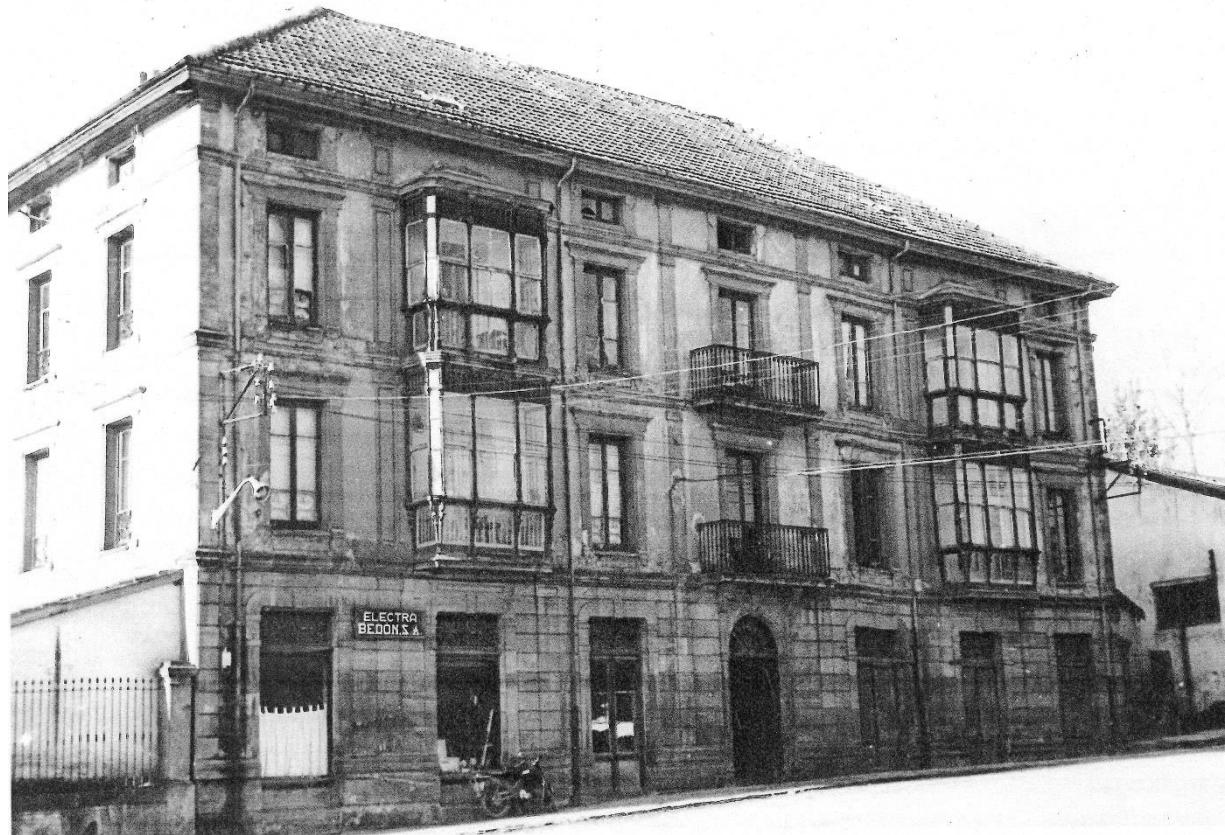
31 - CABEZÓN DE LA SAL 1963 - Edificio Bedón
