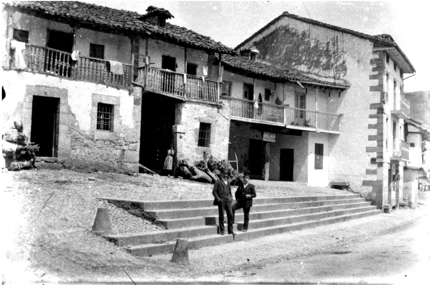
4 - CABEZÓN DE LA SAL 1888 - Calle de la Torre, hoy Paseo Igareda
